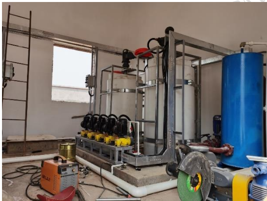
油库污水处理设施-加药装置及厌氧池
