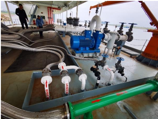
到港船舶生活污水、生产废水接收阀
