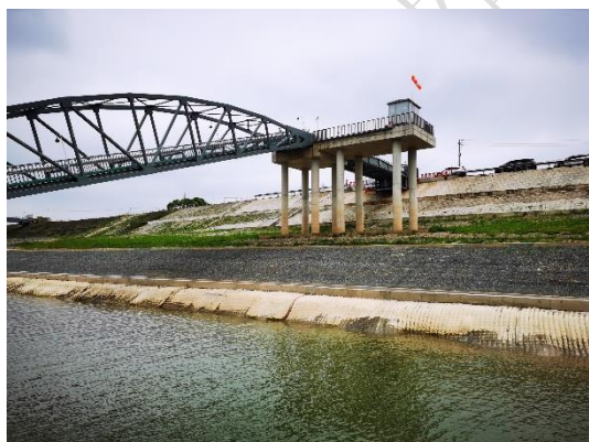
码头区岸坡水下护坡现状
