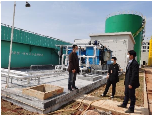
油库废水处理设施-清水池、中间水池、调节池、污泥池合建
