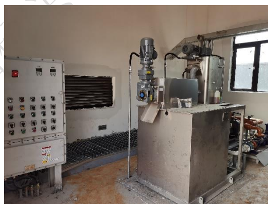
油库污水处理设施-叠螺污泥脱水机及 隔油沉淀池
