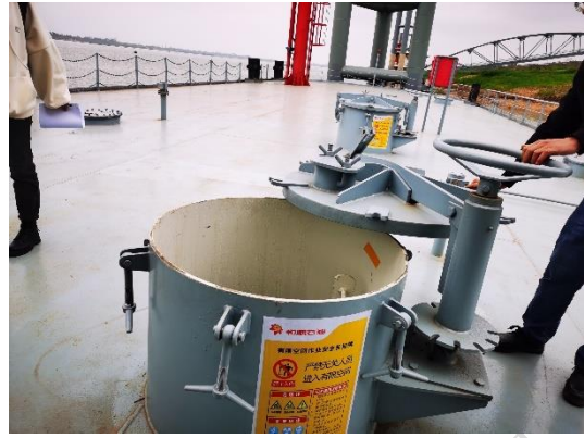
码头废油及油污水分开收集舱
