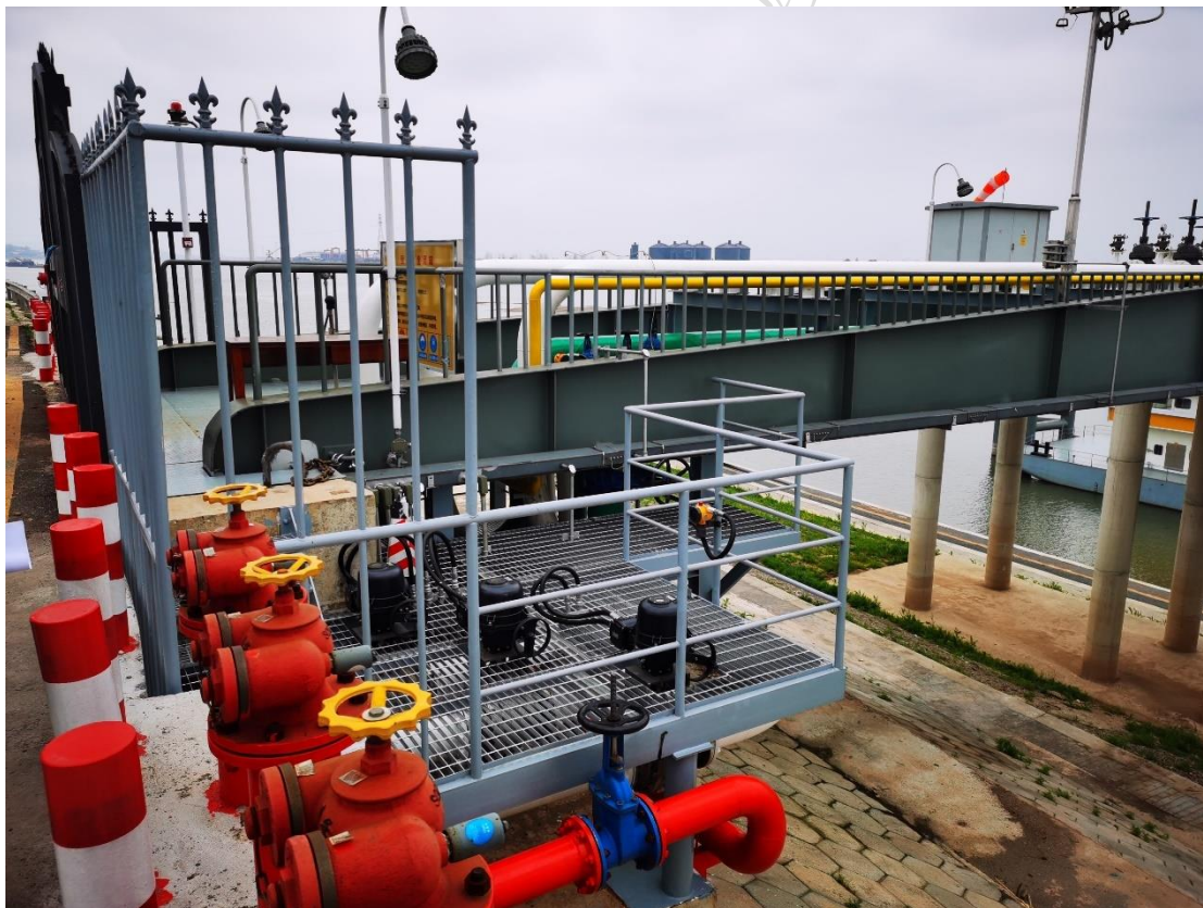
图 4.1.1-1 码头及管线工程穿大堤前阀门设置情况
